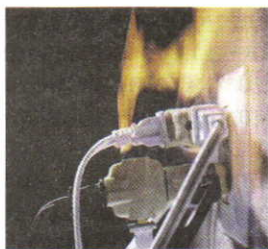
Рис. 89. Короткое замыкание в электропроводке
